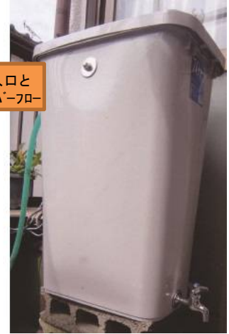
手づくり雨水タンク完成例
