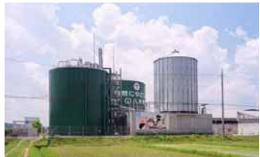
京都府八木町のバイオガス発電プラント
