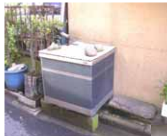
(上)風呂おけをタンクに、手づくり雨水利用
