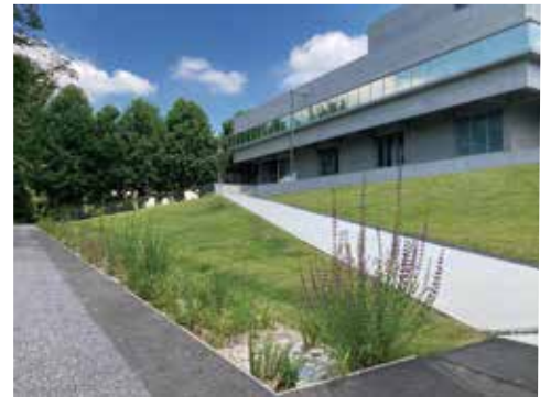
千葉大学附属図書館松戸分館における雨水の見える化と雨庭（レインガーデン）の取り組み
