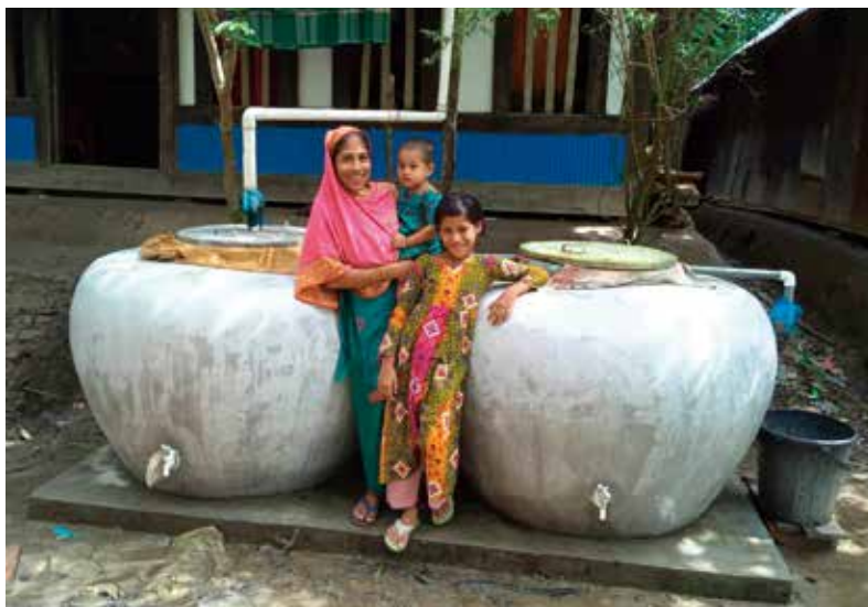
fig.2 天水活用の切り札である「AMAMIZU」は、持続可能性を高めるために、生産、設置および維持管理までの仕組みを地元でビルドインすることを考慮している（提供：村瀬誠）
