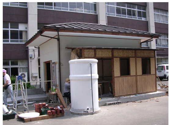
完成間近の雨水ハウス (2005.7.18)
